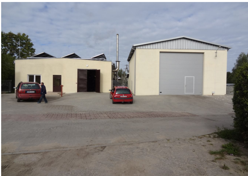
Zmodernizowany budynek kotłowni z kolektorami i budynek magazynu podręcznego
