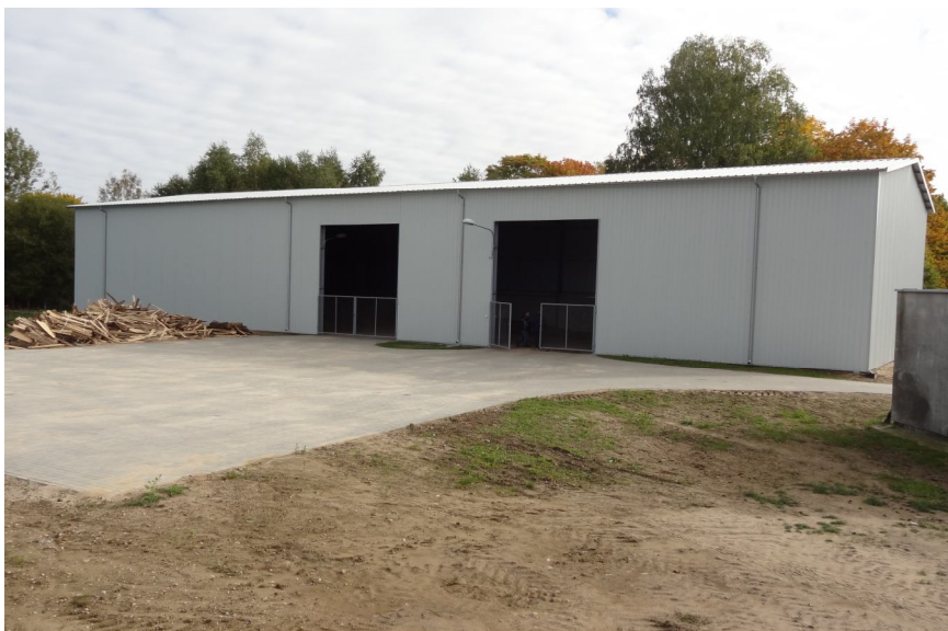
Budynek magazynu głównego
